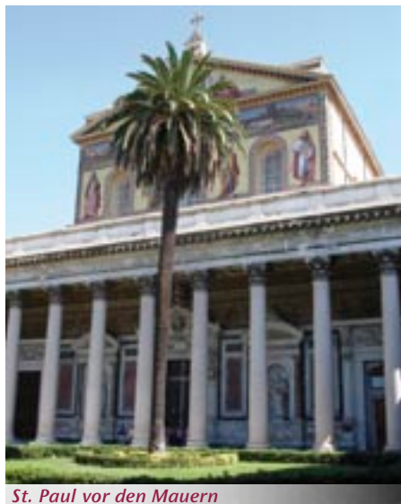
St. Paul vor den Mauern
